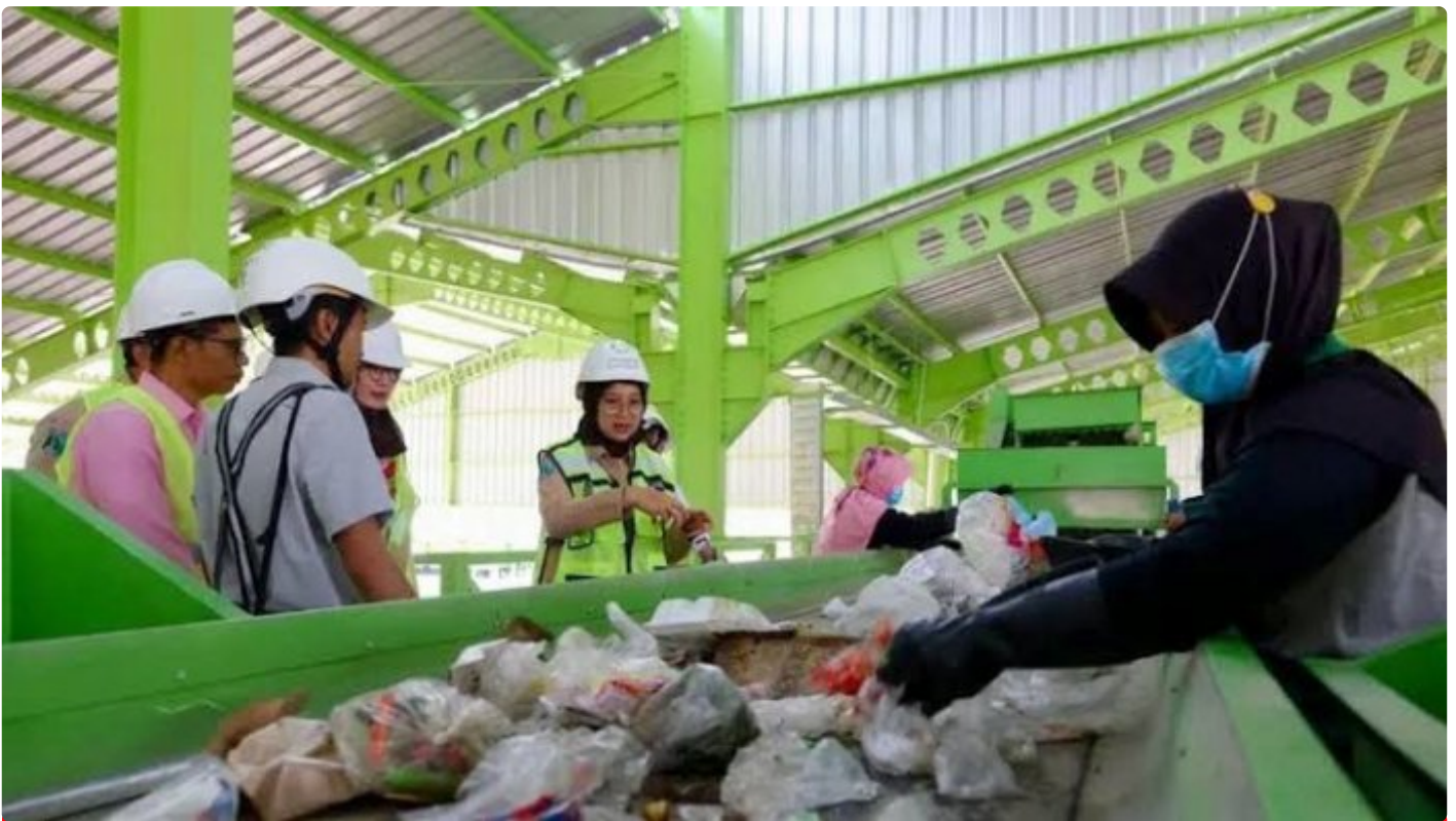
Tempat Pengolahan Sampah Balak Kecamatan Songgon yang diresmikan pada September 2023
